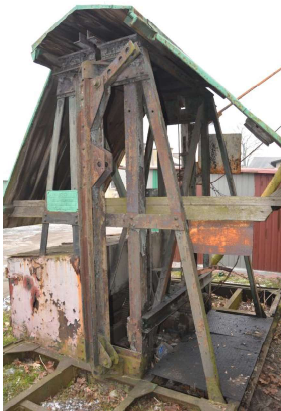
Zdj.3. Żuraw - stan zachowania przed konserwacją– widok z boku
