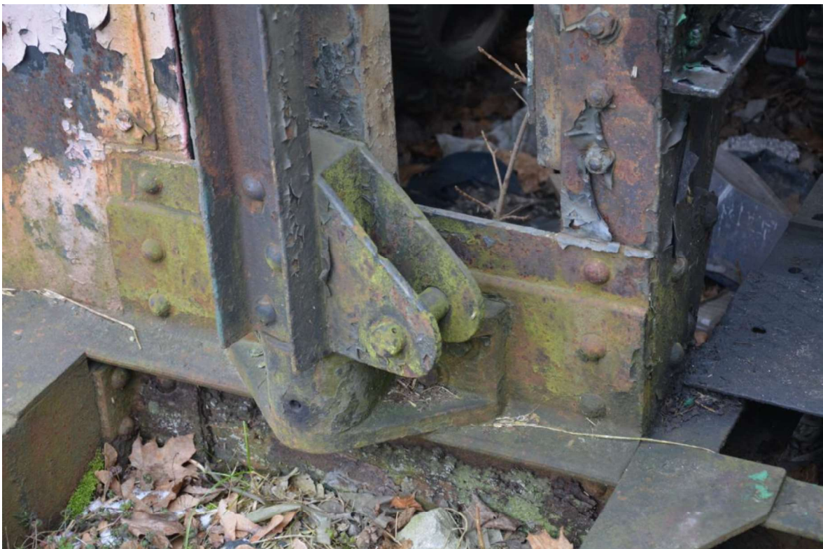
Zdj.8. Żuraw, elementy konstrukcyjne - stan przed konserwacją
