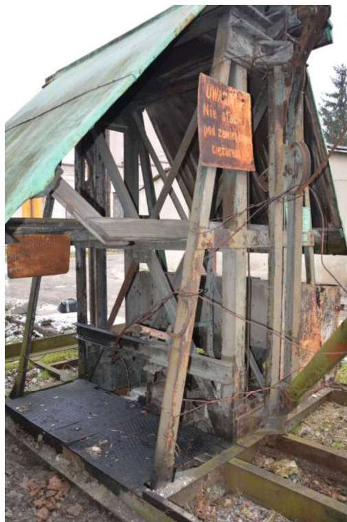
Zdj.2. Żuraw – stan zachowania przed konserwacją – widok z boku
