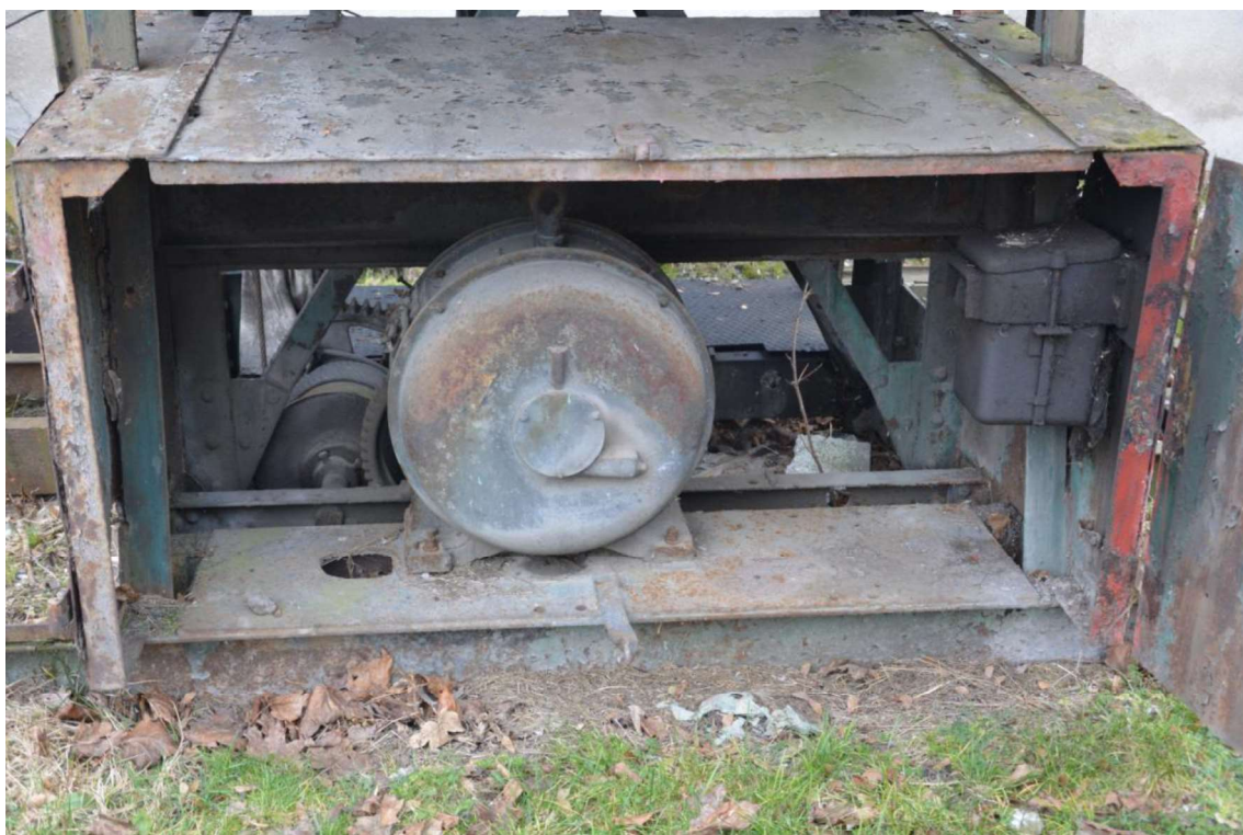
Zdj.5. Żuraw, komora silnika – stan przed konserwacją
