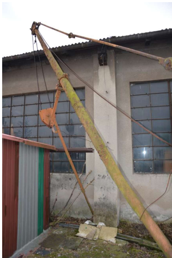
Zdj.4. Żuraw– wysięg, stan zachowania przed konserwacją
