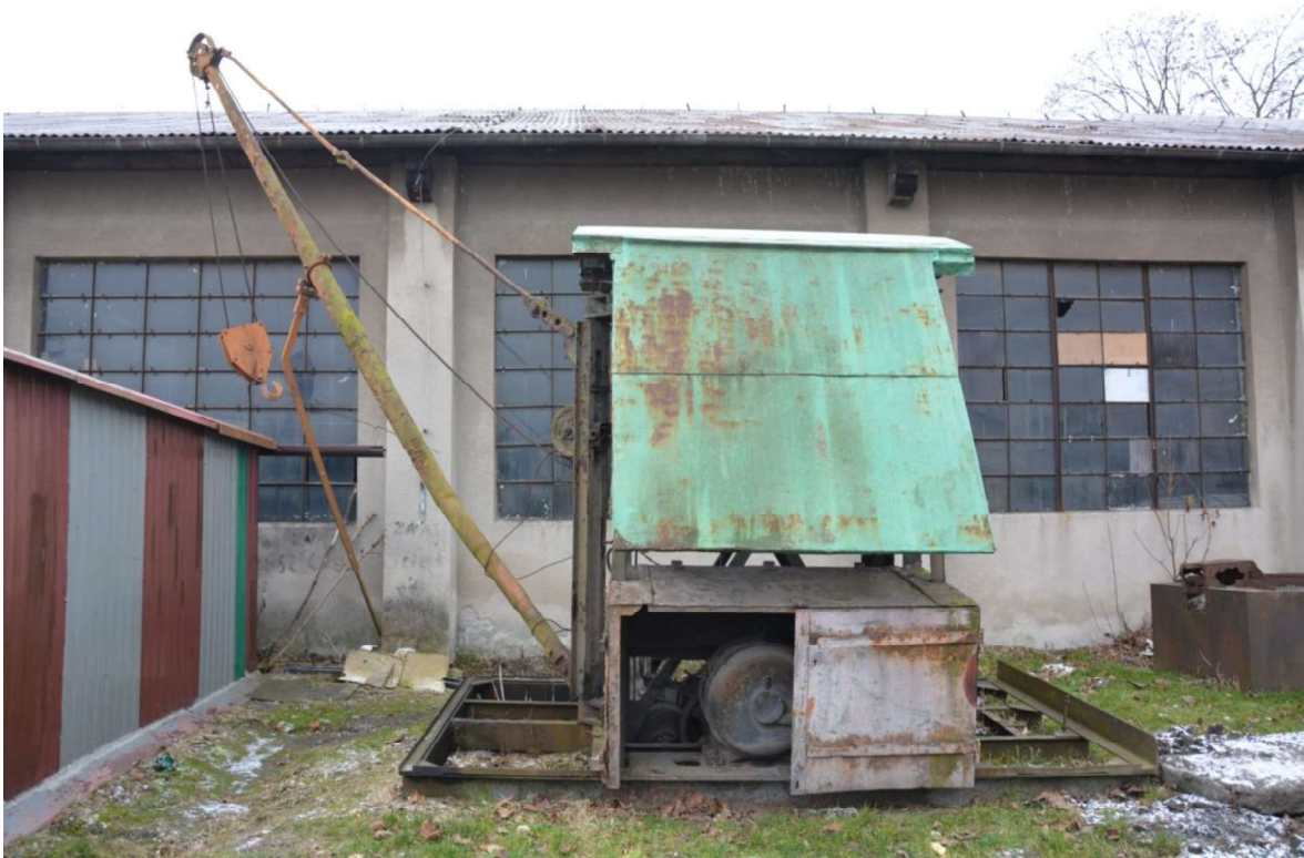
Zdj.1. Żuraw -stan zachowania przed konserwacją – widok ogólny
