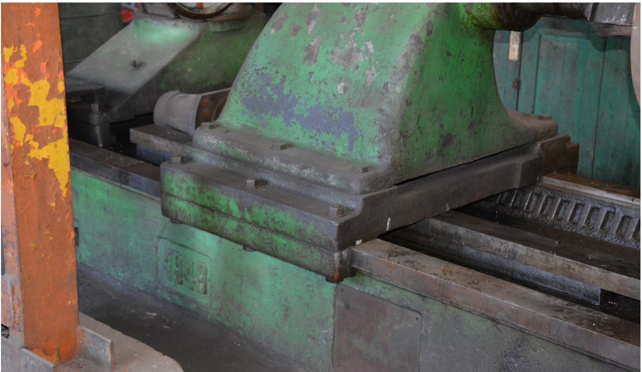
Zdj.12. Stan zachowania przed rozpoczęciem prac – 2023 rok
