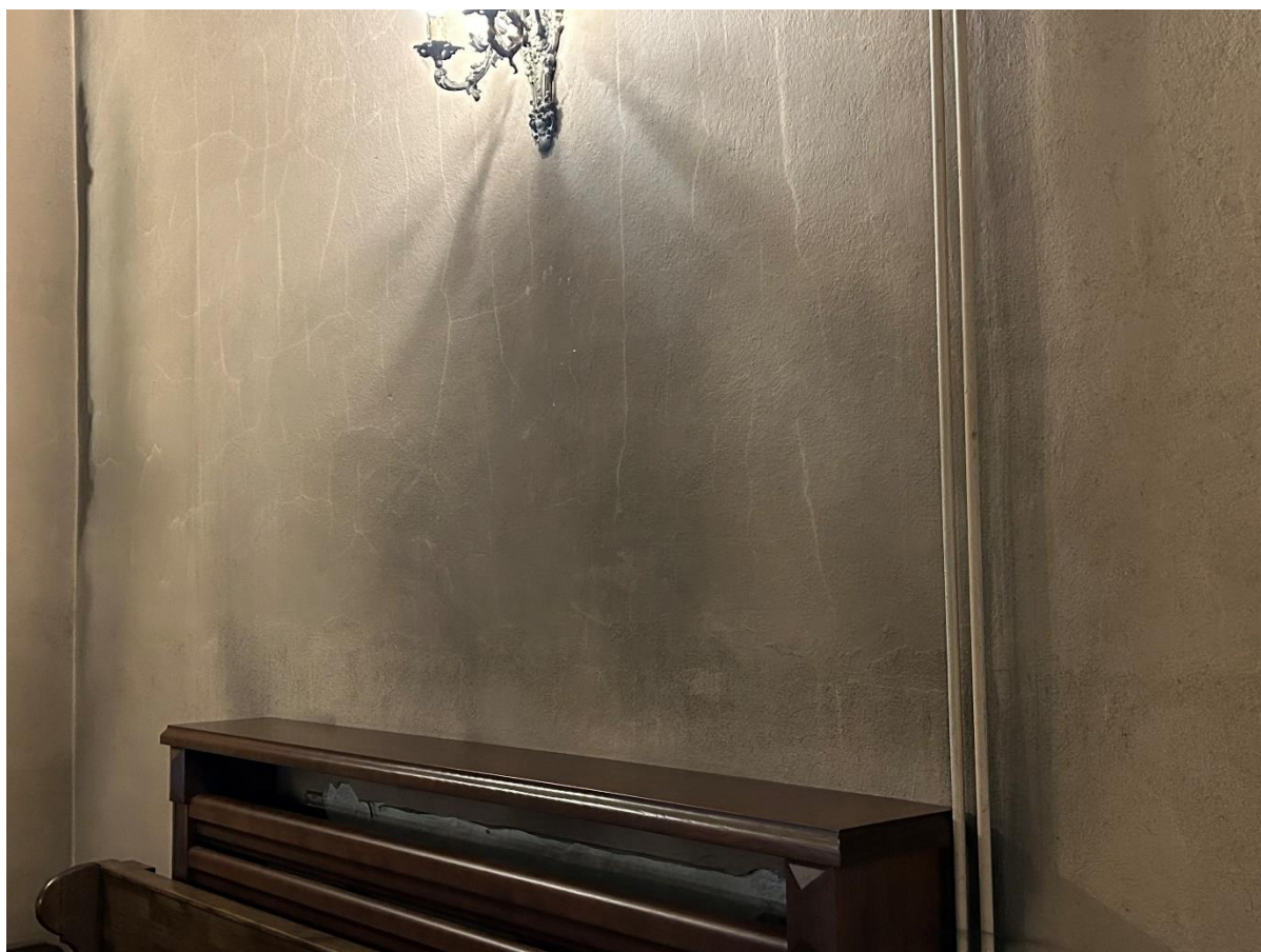
Fot. Kościół parafialny – stan zachowania wypraw tynkarsko-malarskich
