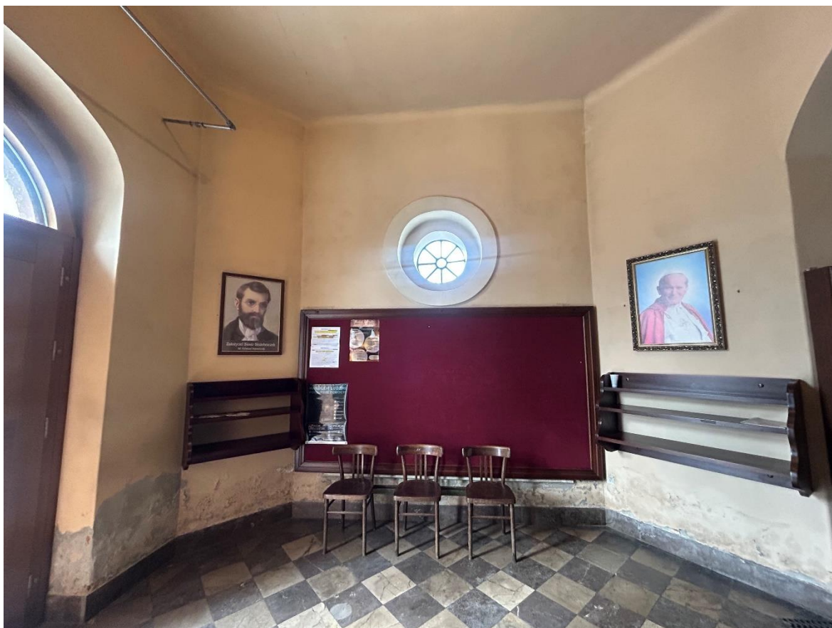
Fot. Krypta południowa. Stan zachowania wypraw tynkarsko-malarskich
