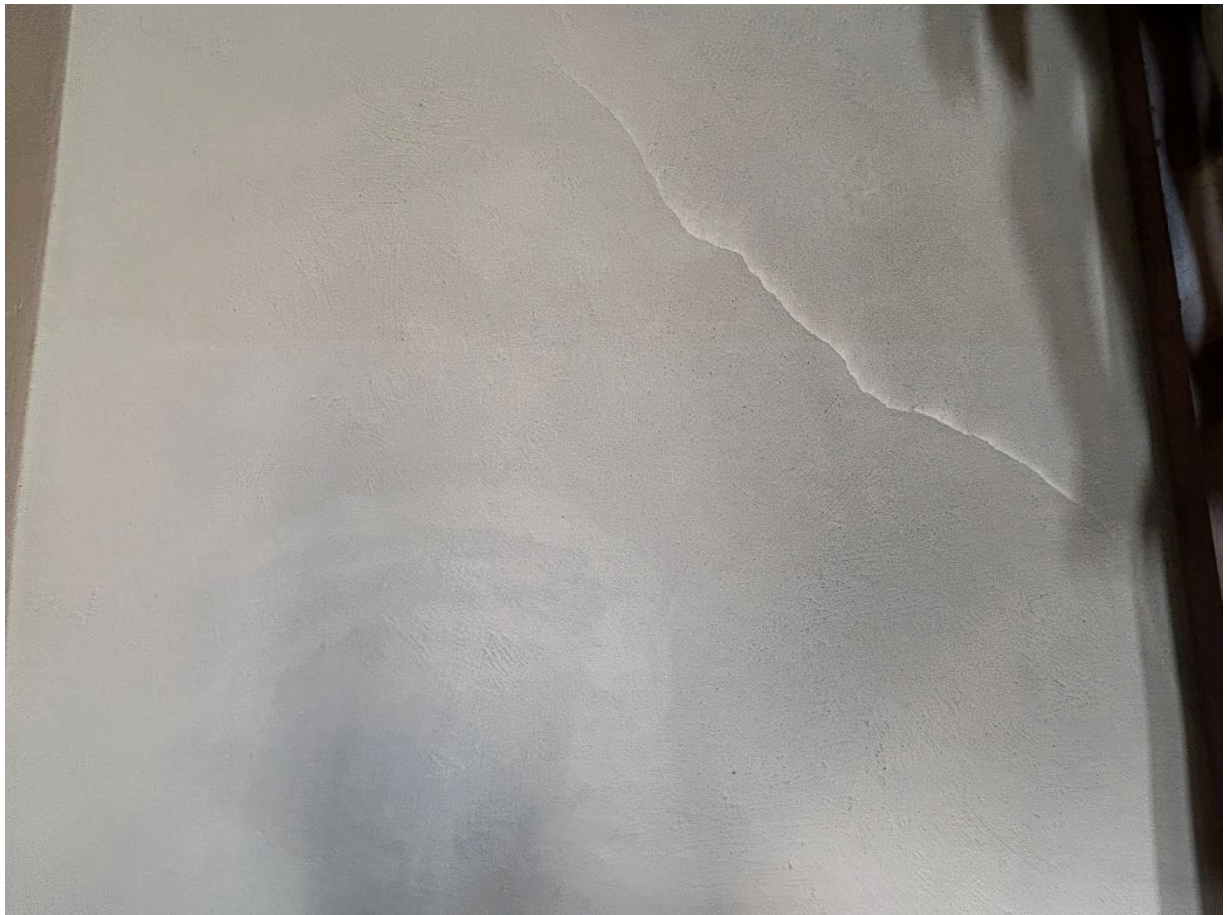
Fot. Kościół parafialny – stan zachowania wypraw tynkarsko-malarskich
