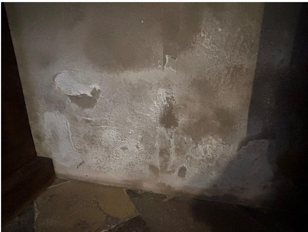
Fot. Kościół parafialny – stan zachowania wypraw tynkarsko-malarskich
