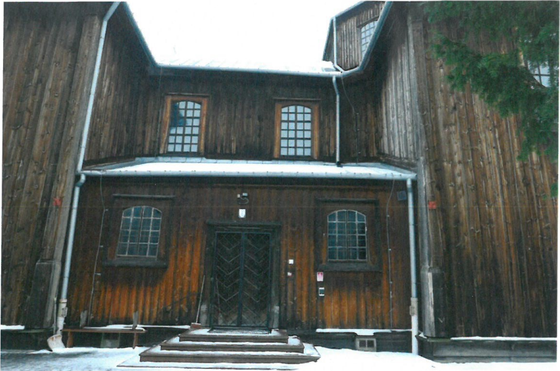
Widok elewacji południowej z wejściem bocznym do kościoła
