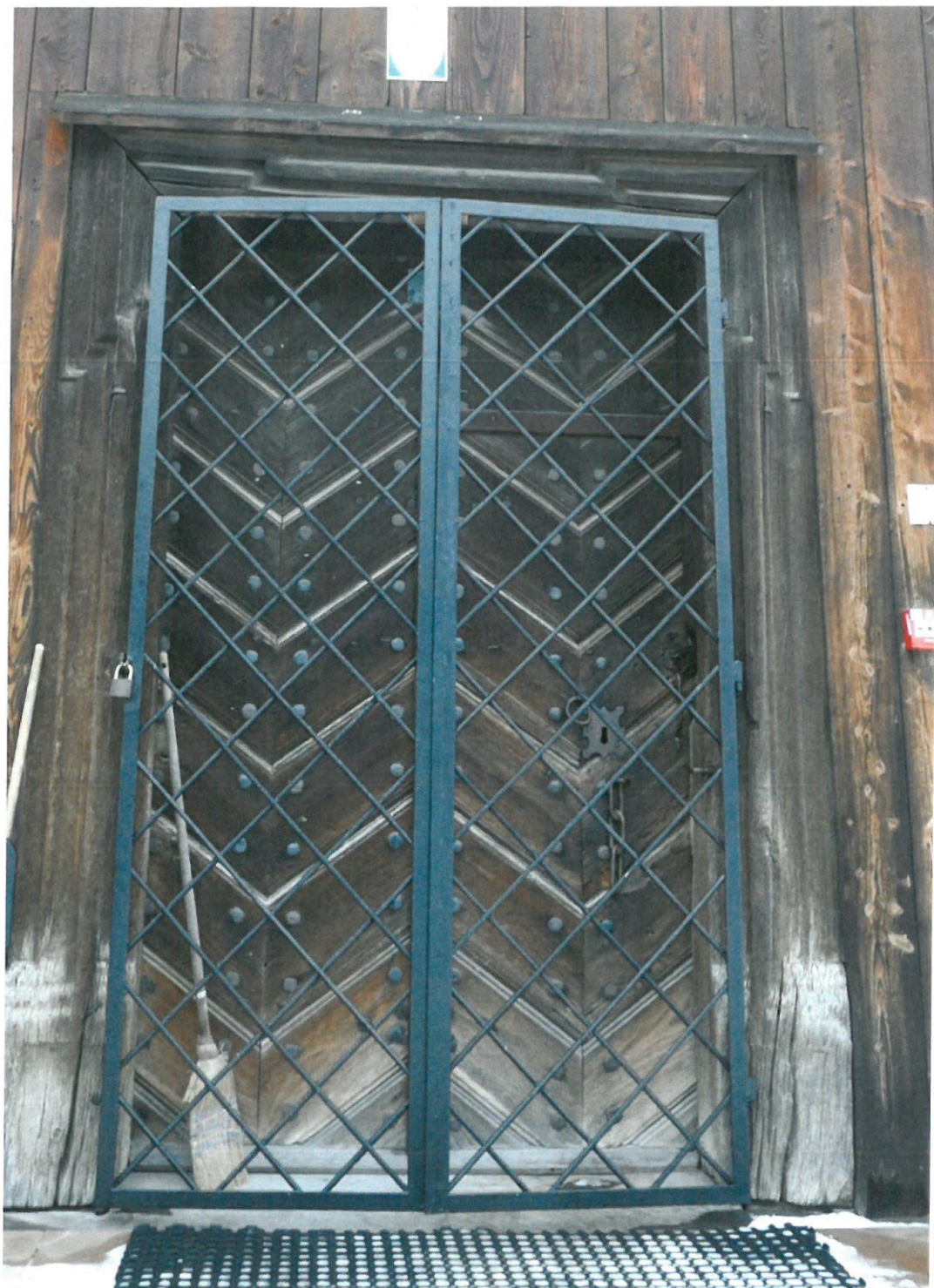
Drzwi i portal elewacji południowej
