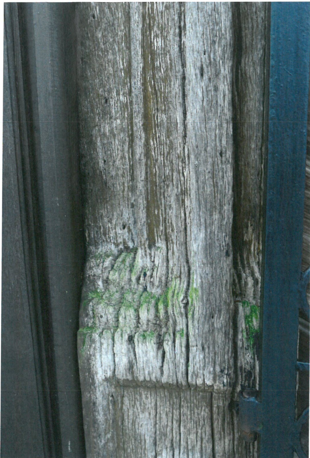
Portal elewacji zachodniej, zbliżenie
