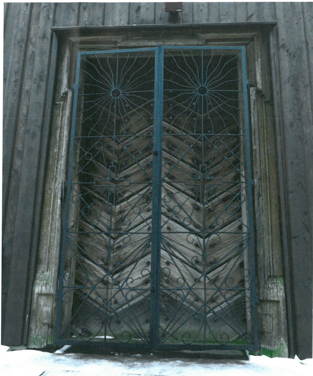
Drzwi i portal elewacji zachodniej
