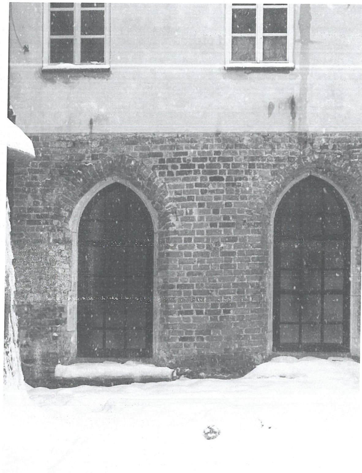
Fot. 2 Jędrzejów. Opactwo Cystersów. Fragment zachodniej ściany wirydarza. Widoczne miejscowe zabrudzenie cegły, zachłapania z zaprawy cementowej, częściowo wykruszone spoinowanie.
